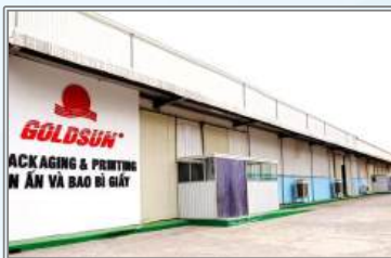
Nhà Máy Gold Sun KCN Quế Võ - Bắc Ninh
