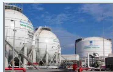
Kho Chứa LNG 1 MMTPA Cảng Thị Vải - Vũng Tàu
