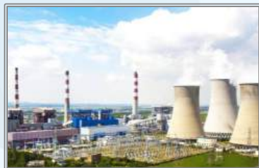
Nhà Máy Nhiệt Điện Nghi Sơn Thanh Hóa
