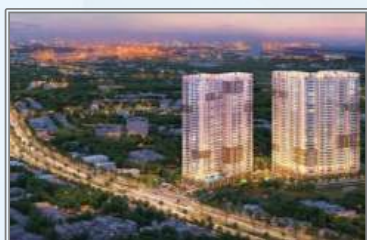
Tòa Nhà Opal Boulevard Bình Dương
