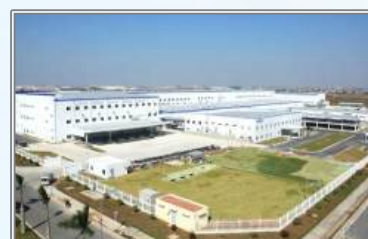
Nhà Máy TOTO GĐ II Hưng Yên
