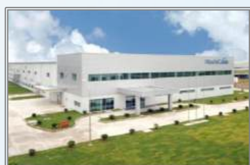
Nhà Máy Hitachi Cable Hải Dương
