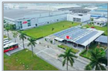
Nhà Máy ABB - Bắc Ninh
