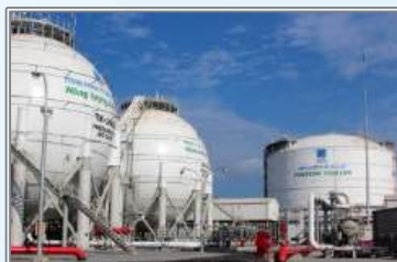
MMTPA LNG Storage Warehouse 1 Thi Vai Port ,Vung Tau
