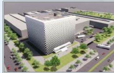
Viettel Data Center (IDC) Hoa Lac
