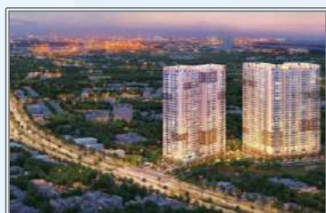
Tòa Nhà Opal Boulevard Bình Dương
