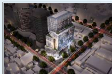
Tòa nhà Techcombank 44 Lý Thường Kiệt Hà Nội
