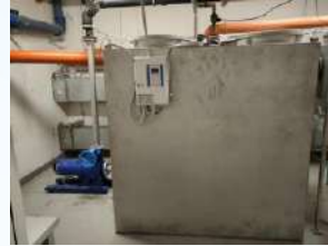
Máy tách mỡ tự động, dùng vòi xả cao áp, bộ điều khiển, van điện tử và bơm tự động. Chất liệu Inox
