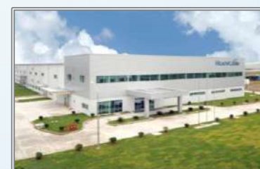
Nhà Máy Hitachi Cable Hải Dương
