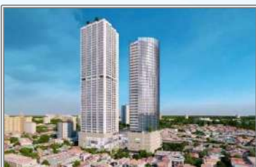
Tòa Tháp FLC Twin Towers Hà Nội
