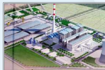
Nhà Máy Nhiệt Điện Hưng Yên
