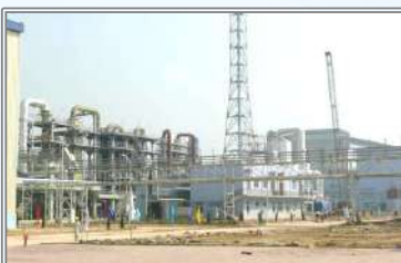
Nhà Máy Chế Biến Khoáng Sản Sakai - Lào
