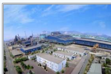
Nhà Máy Tôn Hòa Phát Hưng Yên
