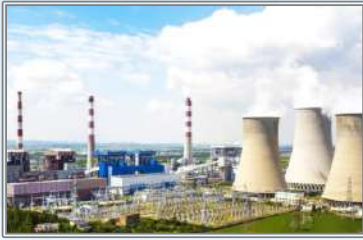
Nghi Son 1 Thermal Power Plant Tinh Gia ,Thanh Hoa
