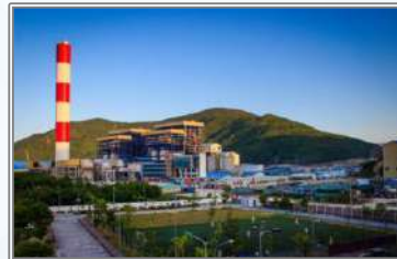
Vung Ang 1 Thermal Power Plant Ky Anh - Ha Tinh
