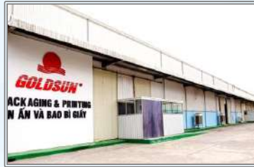
Gold Sun factory Que Vo Industrial Zone, Bac Ninh,
