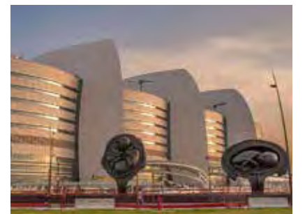
Trung tâm Y tế & Nghiên cứu Sidra - Doha, Qatar Hệ thống nước nóng & hơi nước chìa khóa trao tay
