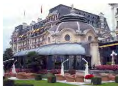
Beau-Rivage Palace - Lausanne, Thụy Sĩ Bồn gia nhiệt nước nóng công suất cao
