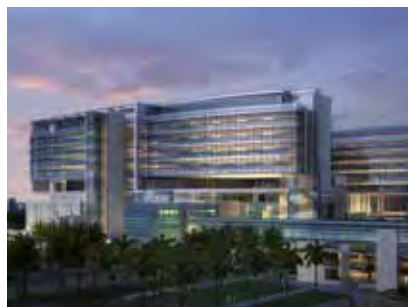
ĐH KH Y tế KS - Riyadh, Saudi Arabia Hệ thống nước nóng & hơi nước chìa khóa trao tay
