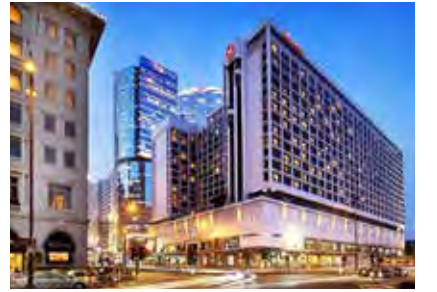
Sheraton Hotel & Towers - Hồng Kông Hệ thống nước nóng & hơi nước chìa khóa trao tay
